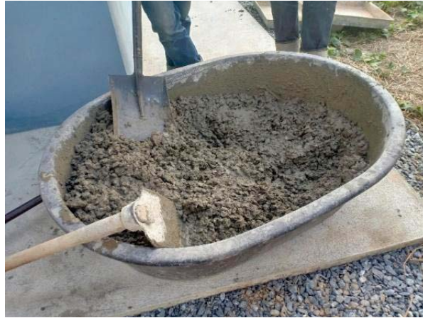
รูปที่ 6 ผสมส่วนผสมคอนกรีตตามอัตราส่วนที่กำหนด
