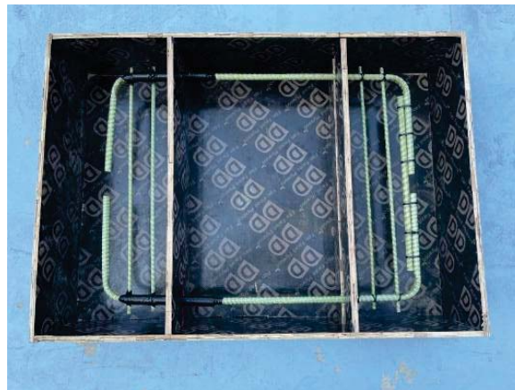
รูปที่ 5 ตำแหน่งที่วาง GFRP Rebar ลงในแบบ
