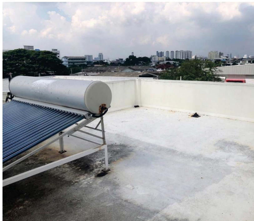
ภาพที่ 1 พื้นที่โล่งดาดฟ้าของอาคาร 3 ชั้น
