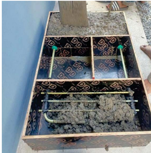
รูปที่ 8 ทำการเทคอนกรีตลงในแบบ
